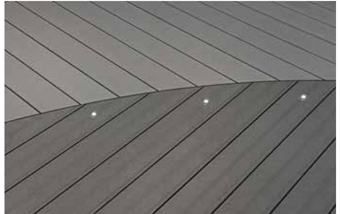
Deski można precyzyjnie docinać nie tylko pod kątem prostym, ale również po łukach.
